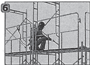
6 2層目の建わくを組み立て、躯体側の足場に交さ筋かいを設置します。
