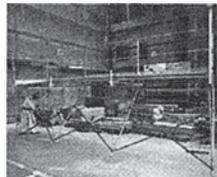
仮組みしたステージをクレーンで1.8~2mほど吊り上げ、吊り材や各斜材間に交差筋交いを取付けます。
