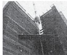
組立てたステージをクレーンで設置場所まで吊り上げます。
