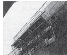
枠組み足場にあらかじめ取付けた金具にステージを取付けます。
