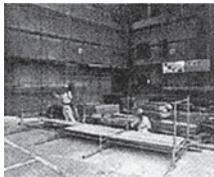
スパンピッチに梁枠を配置し、各々2枚の足場板を取付けるなど、ステージを仮組みします。
