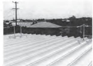
⑧ 親網を取付け、緊張器を用いて、概ね水平になるように緊張して完成です。
