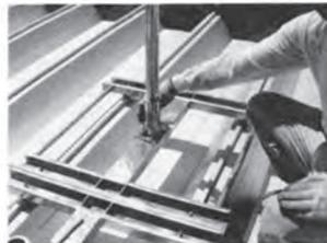
⑥ 支柱ベースソケット部と支柱の穴にトグルピンを貫通させて固定してください。
