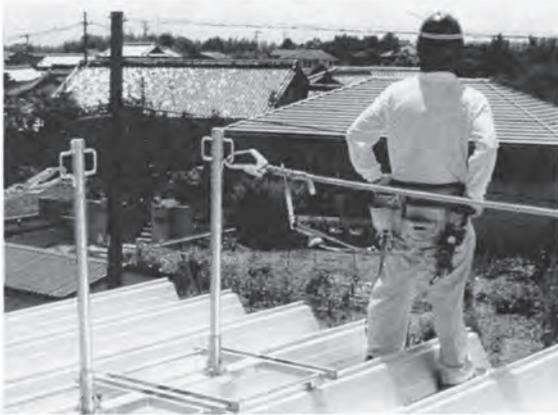
安全帯取り付け設備としての性能・強度を持ち、屋根での作業を安全に行えます。屋根面への負荷が少なく、インパクトレンチで簡単に固定出来ます。さらに支柱を単管パイプ・幅木に取付けることで防護工用支柱となります。
