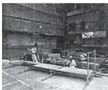
スパンピッチに梁枠を配置し、各々2枚の足場板を取付けるなど、ステージを仮組みします。
