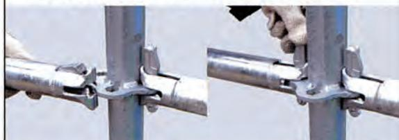
①クサビが収納された状態の手すりを支柱のフランジの真横から差し込みます。
