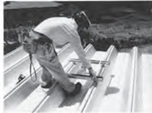
② 設置箇所は、親網システム用支柱の使用基準(次ページ表1及び図1)に従って計測し位置決めをしてください。
